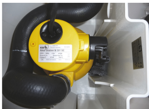
Obr. 14: Montáž čerpadla
