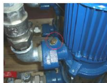
Obr. 6: montáž čidla na odvzdušňovací otvor výtlaku čerpadla
