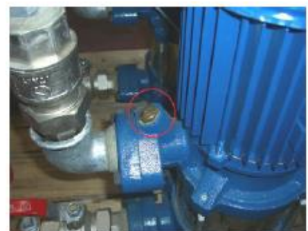
Obrázek 7: Montáž čidla na odvodu vzduchu výtlaku čerpadla
